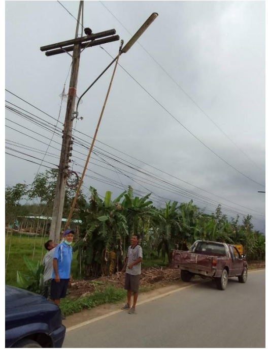
ซ่อมแซมไฟฟ้าแสงสว่างหมู่ที่ 1
