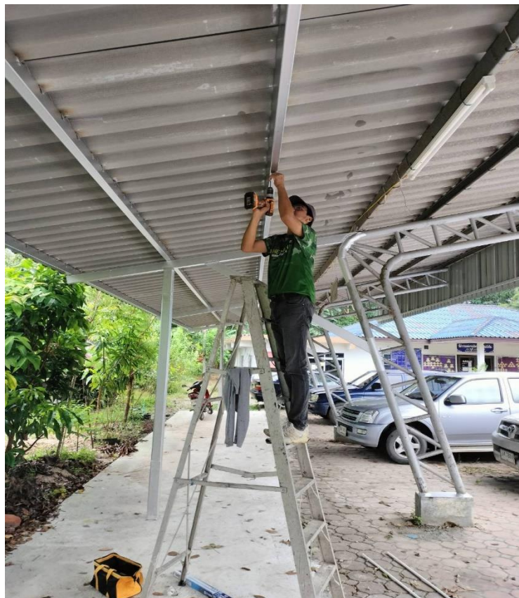
ติดตั้งไฟแสงสว่าง อาคารจอดรถ
