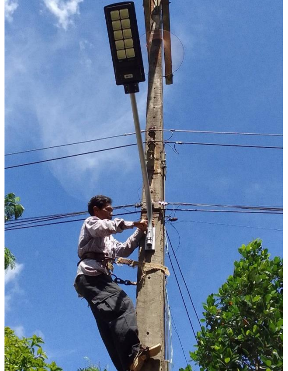
ติดตั้งระบบไฟฟ้าโซลาร์เซลล์ หมู่ที่ 6
