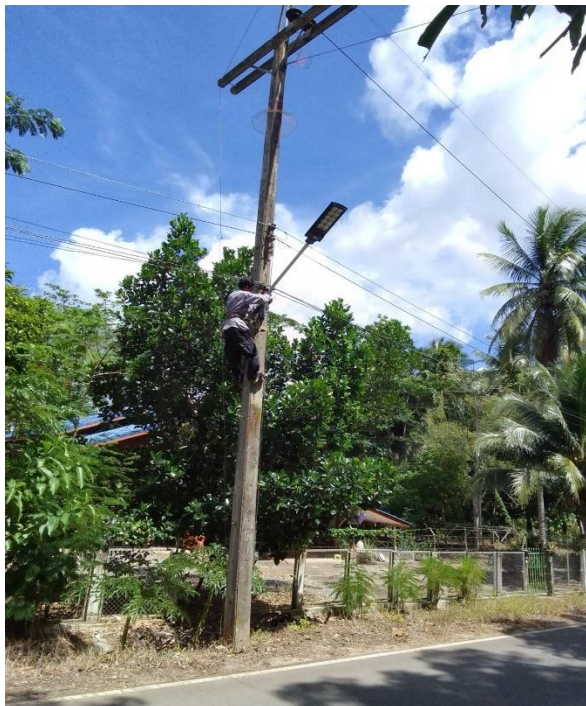
ติดตั้งระบบไฟฟ้าโซลาร์เซลล์ หมู่ที่ 3
