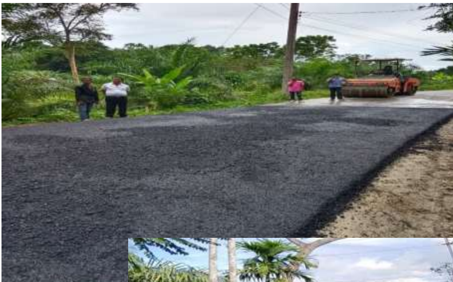
โครงการก่อสร้างถนนลาดยางแบบ แอสฟัลต์ติกคอนกรีตถนนสายสี่แยก สวนป่า-ด่านปริง หมู่ที่ 7
