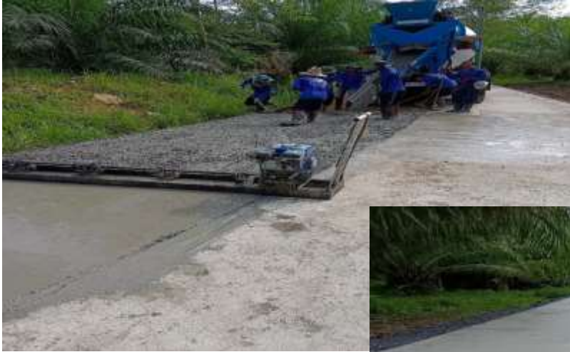
โครงการก่อสร้างถนนคอนกรีต เสริมเหล็กสายควนพลู หมู่ที่ 4
