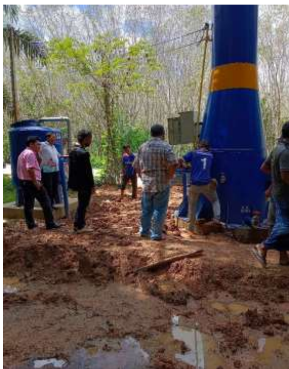
โครงการก่อสร้างถังประปาพร้อมท่อเมนต ( คลองแม่น้ำตรัง ) หมู่ที่ ๒
