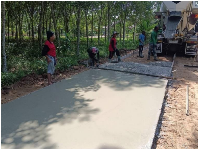
โครงการก่อสร้างถนนคอนกรีตสายบ้านสวน – หุ้งทับควาย หมู่ที่ 6
