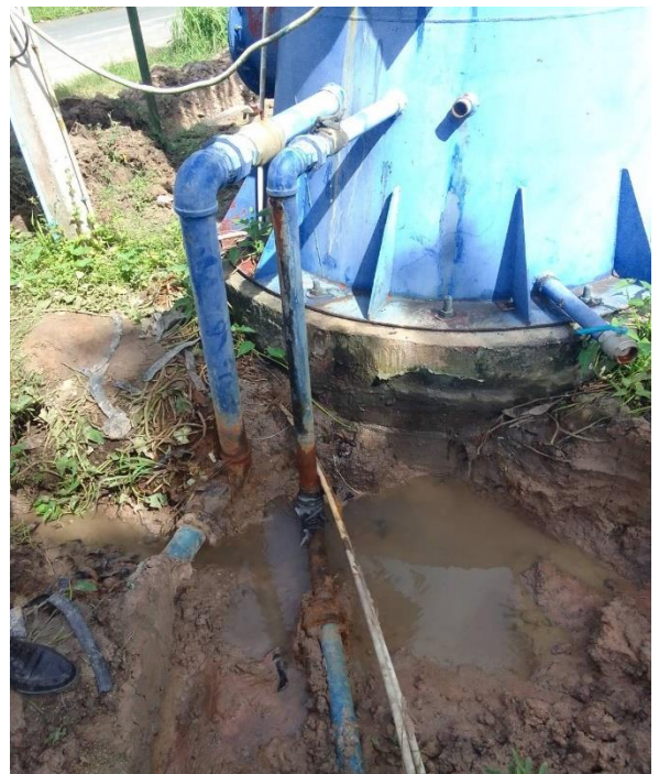
ซ่อมแซมระบบท่อน้ำประปา หมู่ที่ 2
